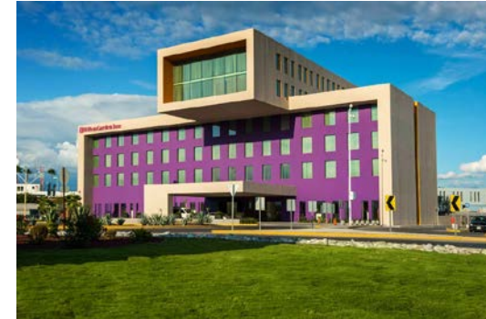
Hilton Garden Inn Monterrey Aeropuerto
